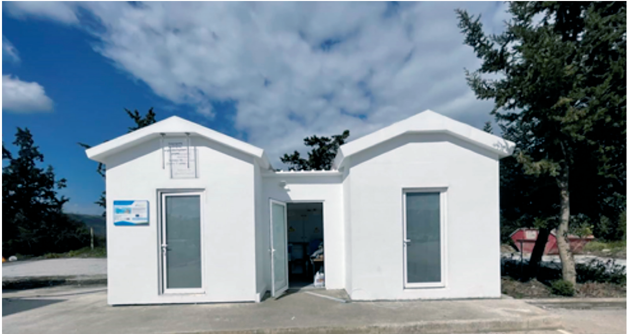
Σχήμα 11 Τα κτίρια επίδειξης (Demo Houses) στην Κρήτη in Crete
