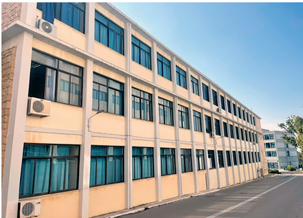
Σχήμα 13 Σχολή Ναυτικών Δοκίμων – Κτίριο διδασκαλίας
